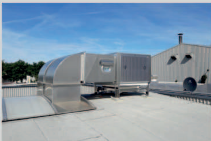
CoolStream S – połączenie boczne z adaptacją pasma świetlnego
