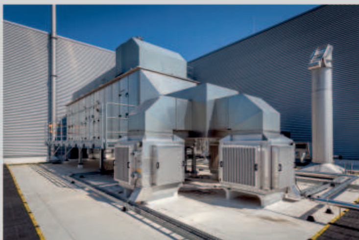
CoolStream V – jednostka pełniąca funkcję czerpni powietrza dla istniejącej centrali wentylacyjnej
