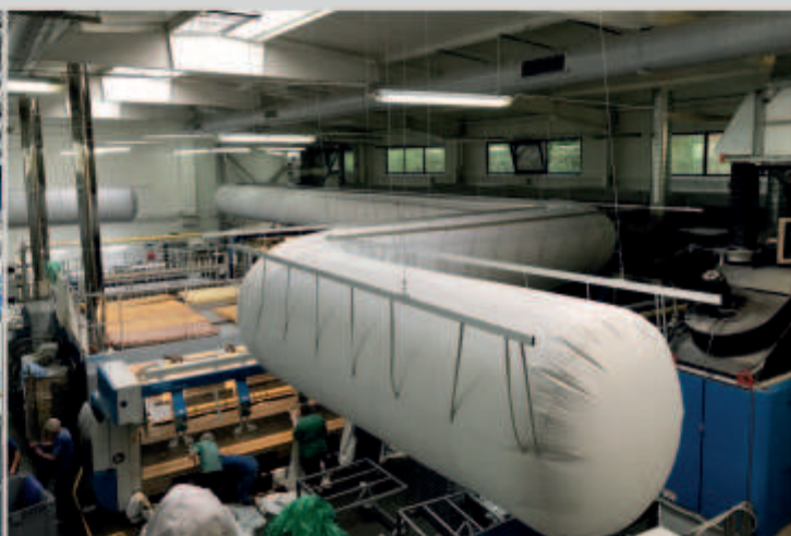
Kanał tekstylny – nawiew wielostronny, mikroperforacja dostosowana do stref przebywania ludzi
