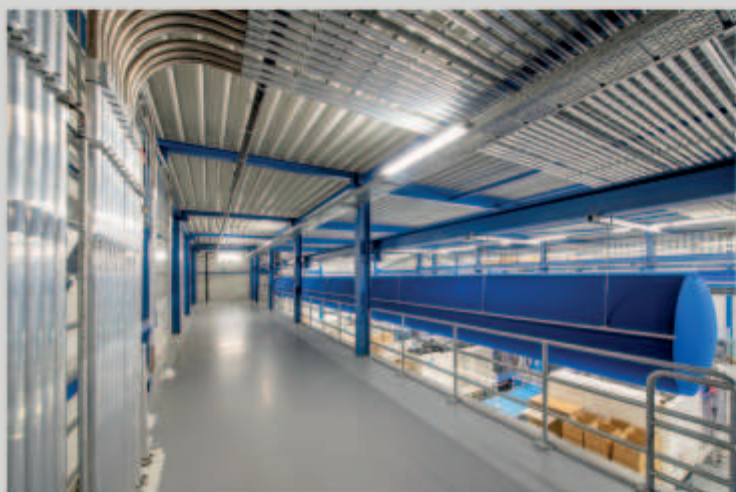
Kanał tekstylny – nawiew jednostronny z dyszami dalekiego zasięgu
